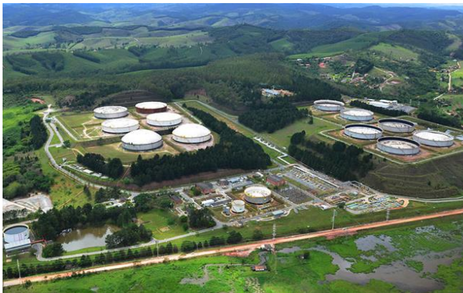
Figura 6.12 - Terminal Terrestre de Guararema
