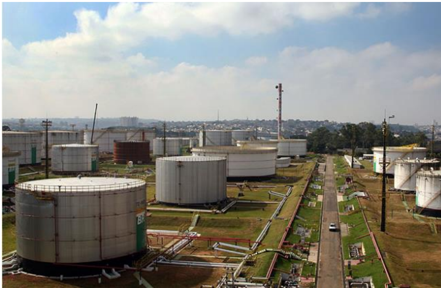
Figura 6.9 - Terminal Terrestre de São Caetano
