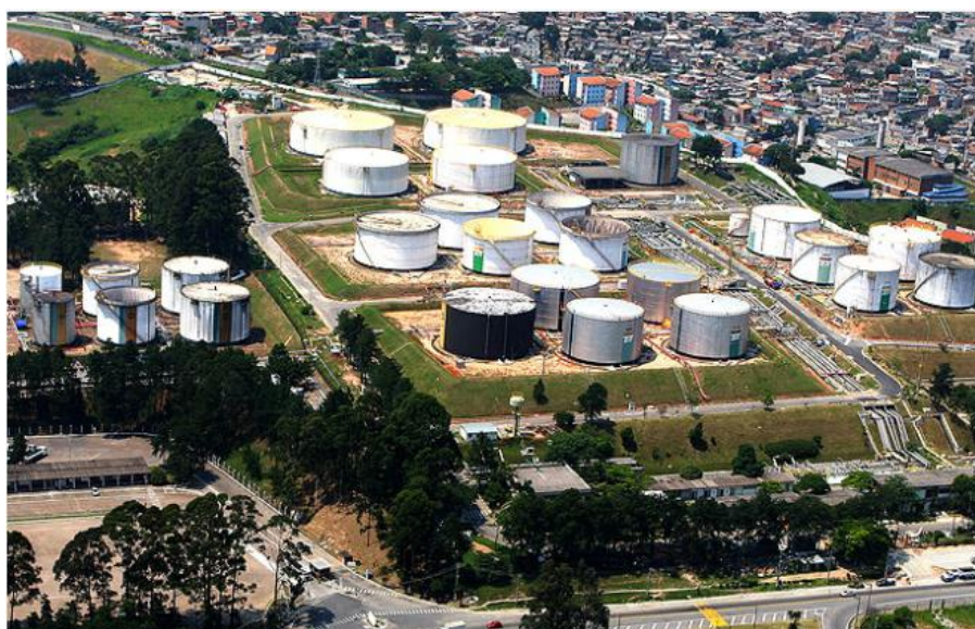
Figura 6.7 - Terminal Terrestre de Barueri Petrobras
