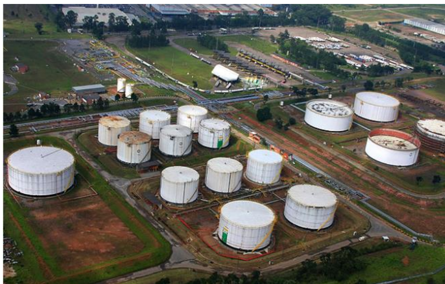
Figura 6.8 - Terminal Terrestre de Guarulhos
