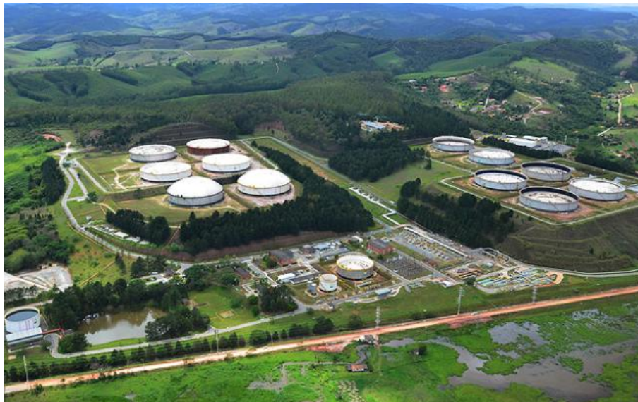
Figura 6.12 - Terminal Terrestre de Guararema
