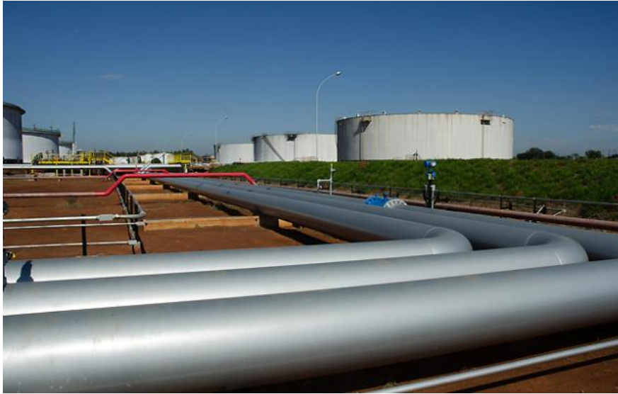
Figura 6.10 - Terminal Terrestre de Paulínia
