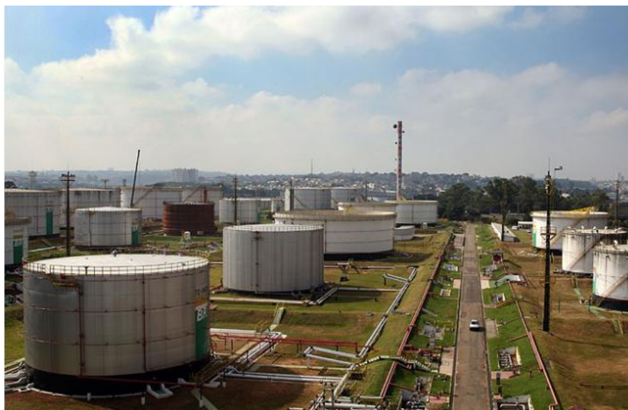
Figura 6.9 - Terminal Terrestre de São Caetano
