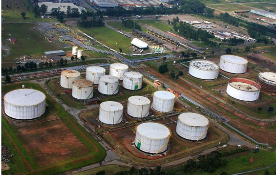
Figura 6.8 - Terminal Terrestre de Guarulhos
