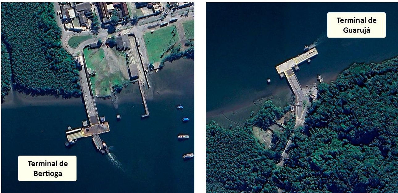
Figura 4.19 - Imagens aéreas dos terminais da travessia Bertioga - Guarujá
