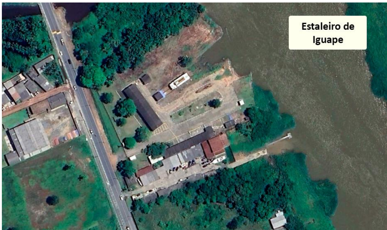
Figura 4.59 – Imagem aérea do Estaleiro em Iguape
