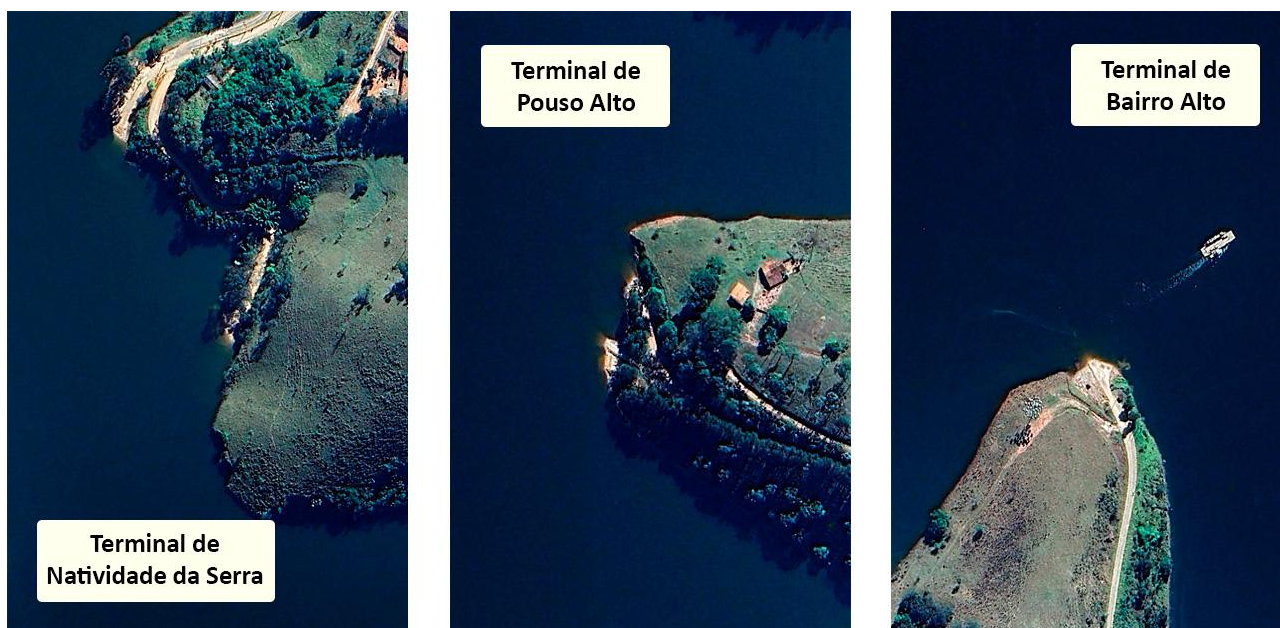
Figura 4.45 - Imagem aérea dos Terminais de Natividade da Serra, Pouso Alto e Bairro Alto
