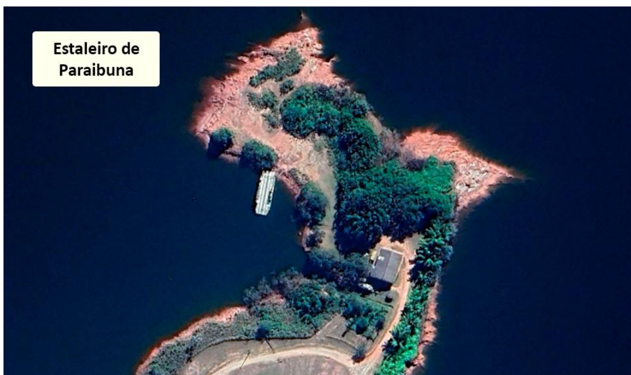
Figura 4.62 – Imagem aérea do Estaleiro de Paraibuna
