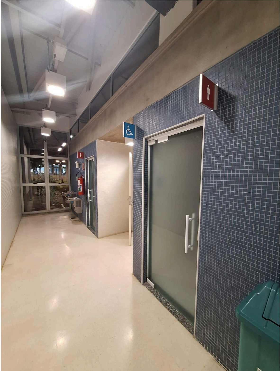
Corredor dos banheiros – masculino, feminino e PCD.
